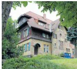
Die noch unsanierte Seite der Villa vom großen Garten aus gesehen.
