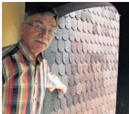
Rudolf Stöhr zeigt auf die teils originalen, teils neuen Dachschindeln aus Holz.
